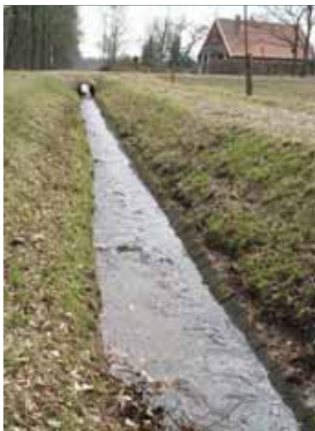
De Haartse Waterleiding: beekbedding met bestrating en zeer hoge stroomsnelheid
