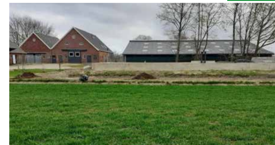
kuilvoerplaats na uitvoering
